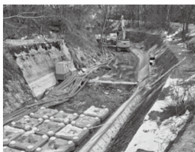
砥川上流の工事現場
